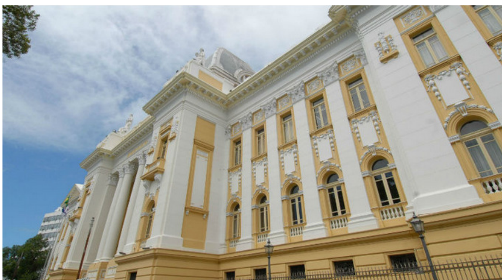
Fachada do TJPE. Foto: Renato Spencer/ Acervo JC Imagem
