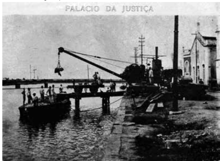
Fotografia 3 – Abastecimento de materiais para a construção do Palácio da Justiça
