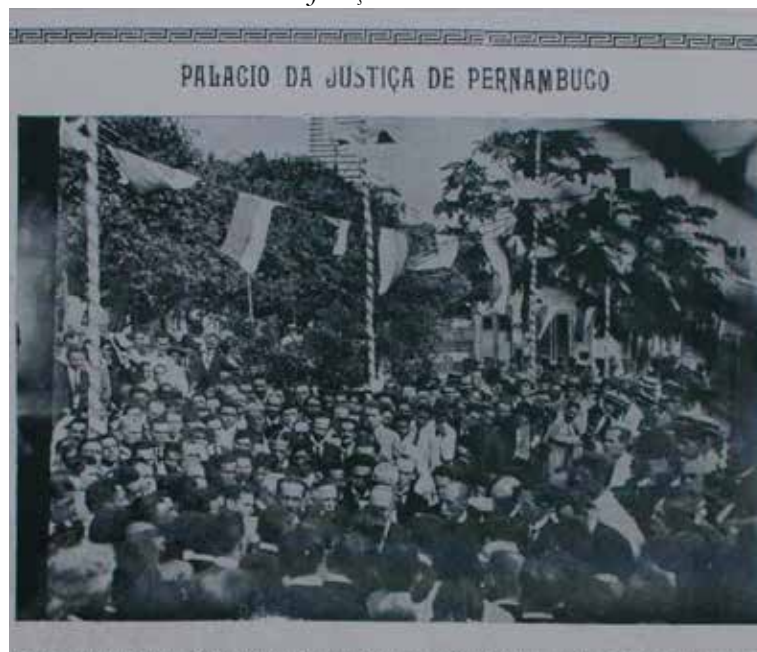
Fotografia 1 – Cerimônia do ato de lançamento da Pedra Fundamental do Palácio da Justiça
