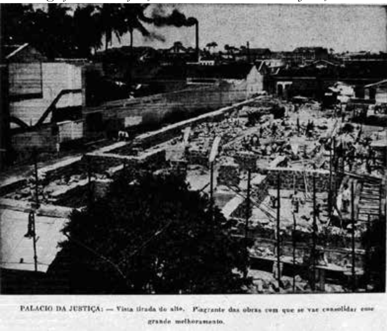
Fotografia 2 – Edificação das bases do Palácio da Justiça
