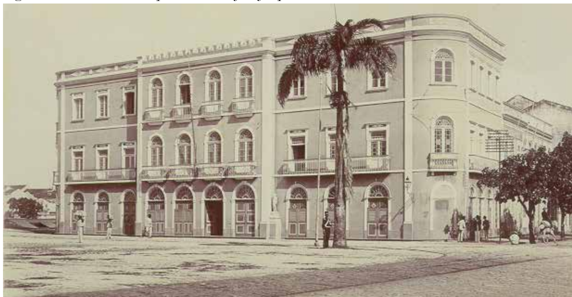
Figura 6 - Prédio construído para o médico José Joaquim de Morais Sarmiento
