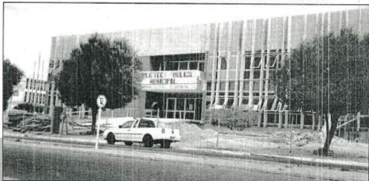
O prédio, com 3.200m², foi construído em 1975 para abrigar a Biblioteca Municipal da Petrolina
