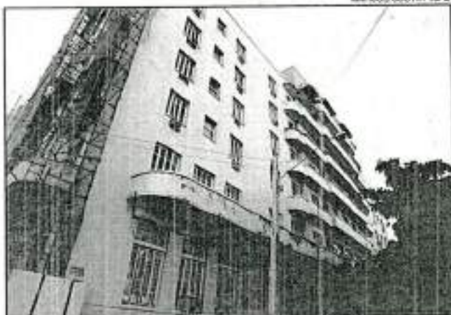
As obras de recuperação do prédio devem ser concluídas em outubro
