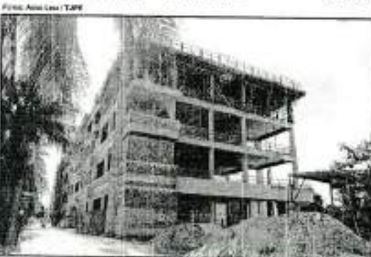
O novo fórum de Olinda já está em estrutura.
