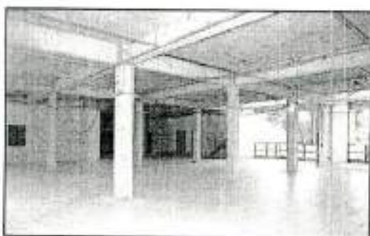
O novo fórum de Olinda já está em estrutura.
