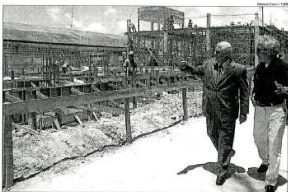
Fausto Freitas (E), visita o novo Fórum de Olinda, acompanhado pelo responsável técnico da obra, engenheiro Luiz Arnaldo de Melo. A nova instalação contará com 7.413,70 m² e poderá abrigar mais sete salas varas
