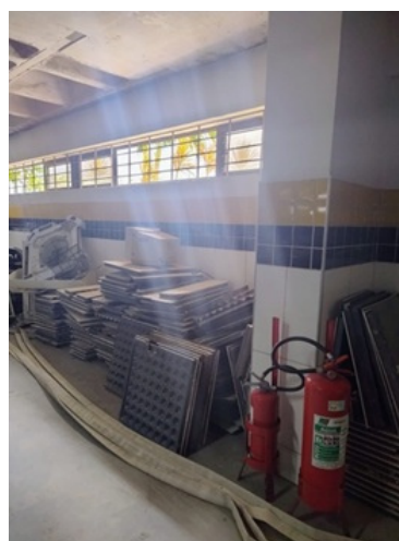
Depósito de sobras e equipamentos em desuso
